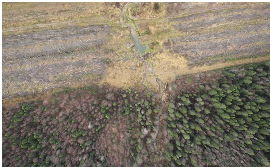
Рис. 4. Пример «сырого» беспилотного снимка трассы МГ. Необорудованное пересечение трассы МГ с водотоком
