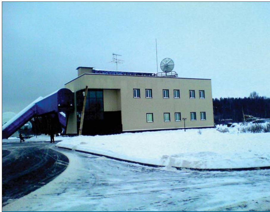
Рис. 2. Размещение ЗС УМО на крыше здания телекоммуникационного центра ОАО «Газпром космические системы»
