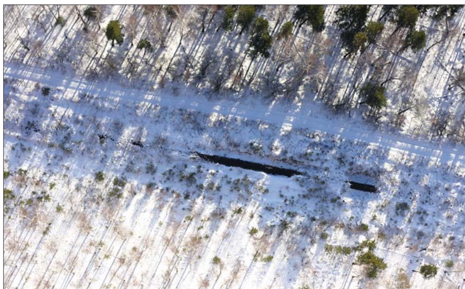
Рис. 5. Пример «сырого» беспилотного снимка трассы МГ. Выход трубы МГ на поверхность
