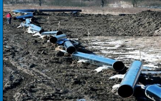
Укладка трубопровода в траншею
