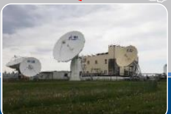
ТЕЛЕПОРТ, РЕЗЕРВНЫЙ ПУНКТ УПРАВЛЕНИЯ
