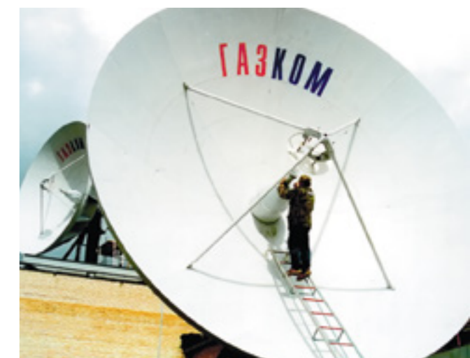
Монтаж антенной системы ЦУП «Ямал»
