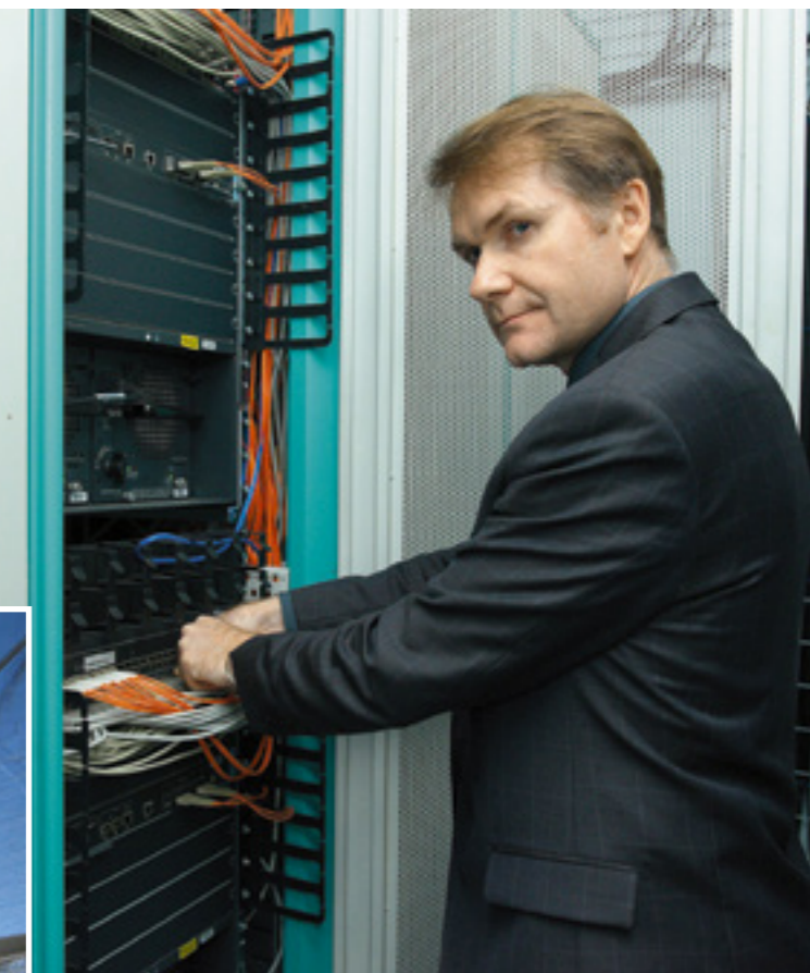
В.В. Кошельков контролирует подключение серверного оборудования на ТКЦ, г. Щелково
