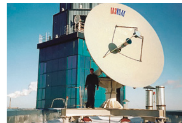
Земная станция спутниковой связи, г. Сургут
