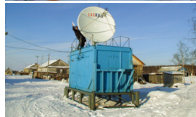
Монтаж передвижной станции спутниковой связи в контейнерном исполнении, Кутольюган
