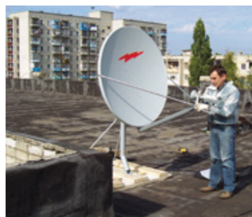
Монтаж антенны, МОУ Лицей г. Уварово, Тамбовская область
