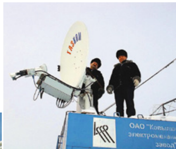
О.М. Лузан и В.И. Петров устанавливают антенную систему ПЗССС Пуртазовская, 2004 год
