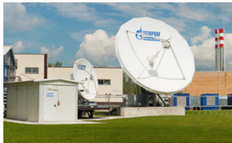
Земная станция центральной станции спутниковой связи (ЗС ЦССС) 2Щ
