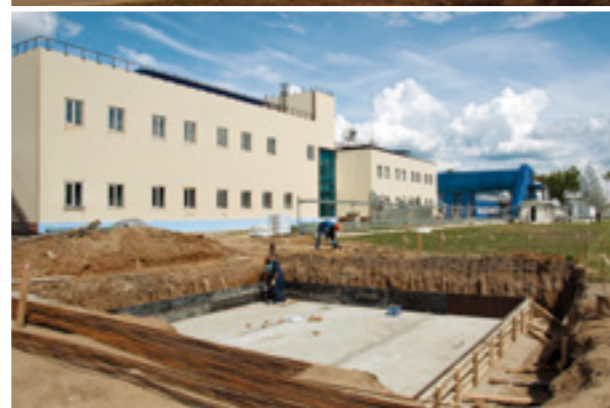
Закладка фундамента антенных систем
