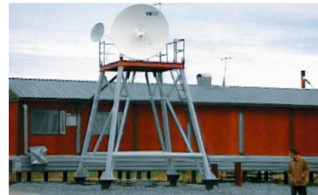
Первая земная станция спутниковой связи ОАО «Газком», п. Ямбург
