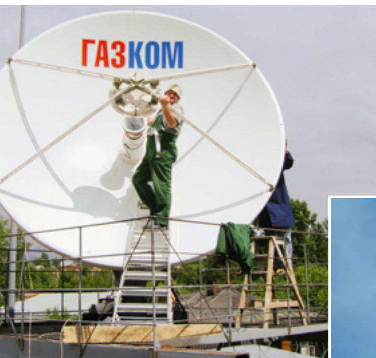
Ю.Ю. Павлов производит монтаж облучателя антенны ЗС в г. Томск, 2006 год
