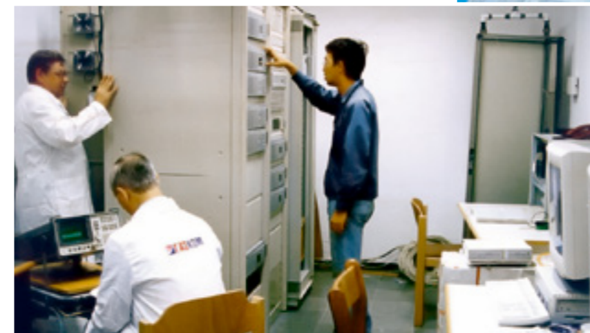
Центральная станция системы спутниковой связи ООО «Межрегионгаз»
