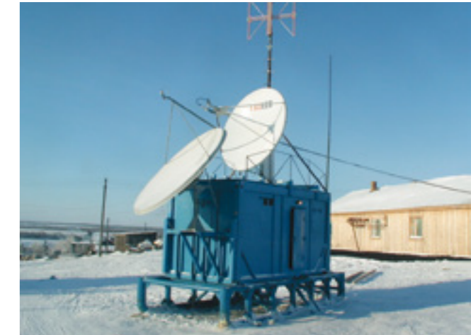
Передвижная станция спутниковой связи в контейнерном исполнении, Кутопьюган
