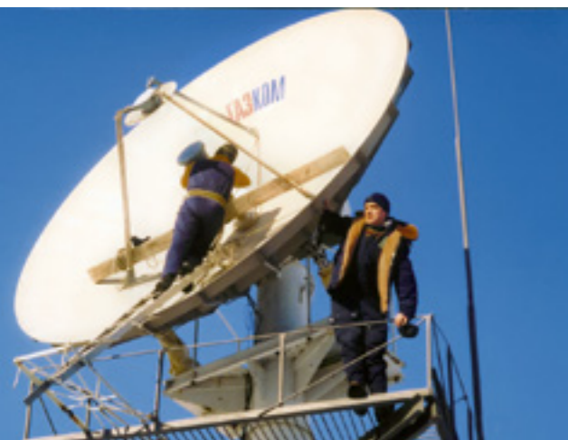
Монтаж антенны земной станции спутниковой связи, г. Тюмень
