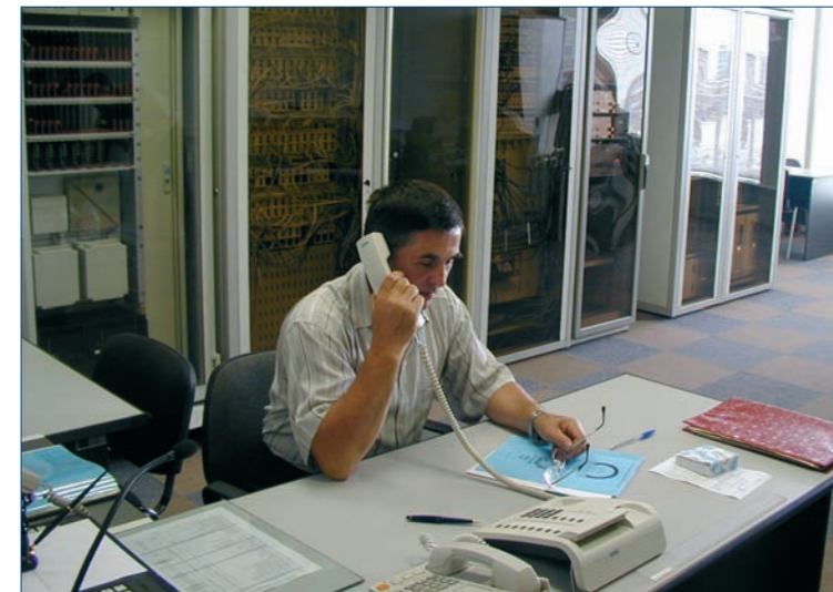
Оператор локальной сети Центра управления полетами спутников "Ямал"
