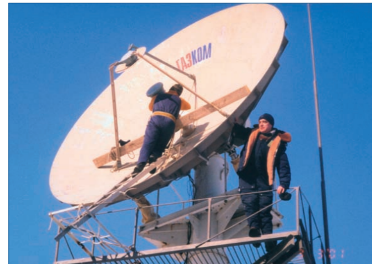
Монтаж антенны земной станции спутниковой связи, г. Тюмень
