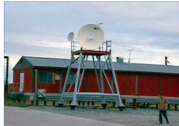
Первая земная станция спутниковой связи ОАО "Газком", п.Ямбург
