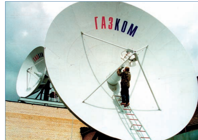
Монтаж антенного комплекса ЦУП "Ямал"
