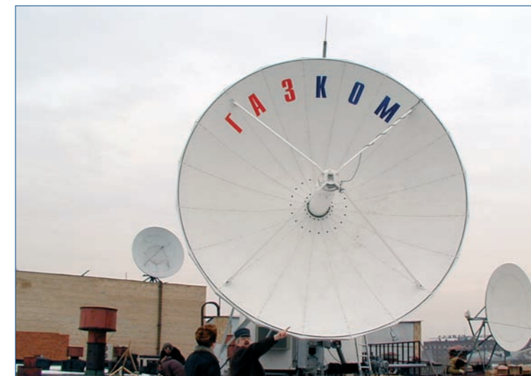
Передающая антенна центра спутникового цифрового телевидения
